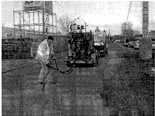
Traitement de la fissure à l'arrière de l'atelier
