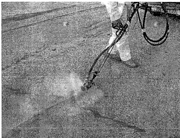
Sablage de la fissure simultanément à l'application du mastic à l'aide d'une sableuse automatique
